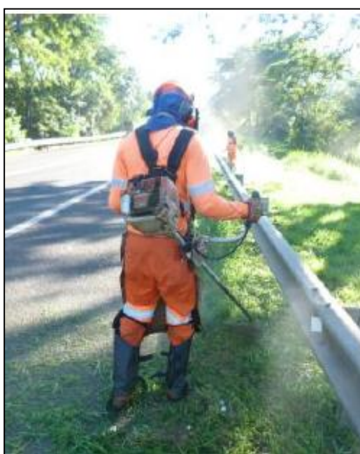
Figura 25 – Operação da roçadeira com ferramenta de corte fio de nylon
